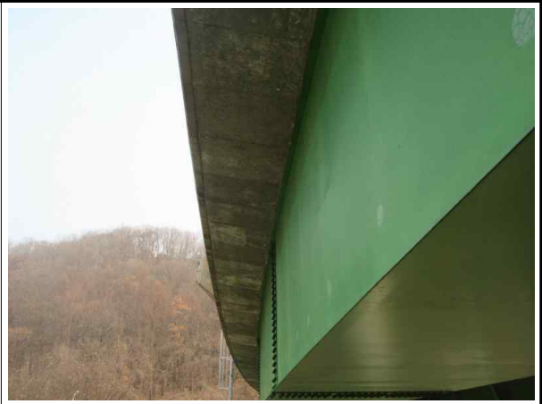
거더 외부 전경
