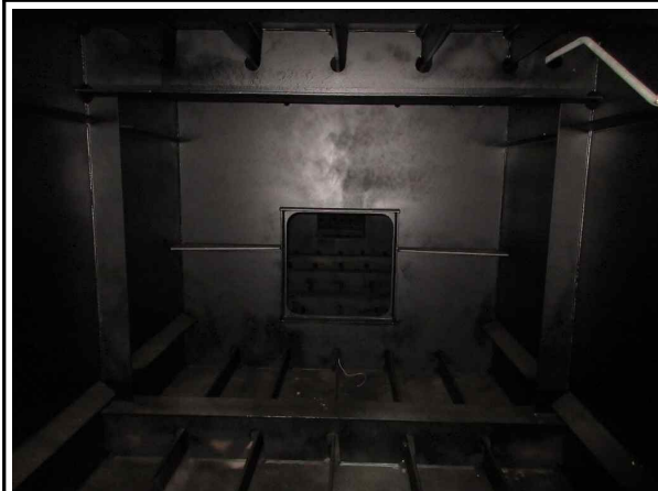
거더 내부 전경
