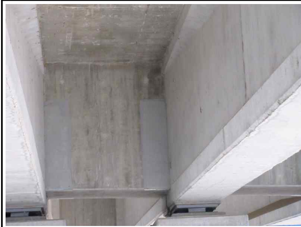
거더 내부 전경
