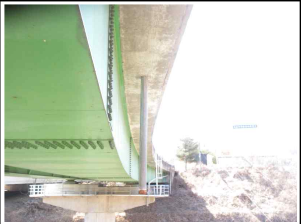
거더 외부 전경
