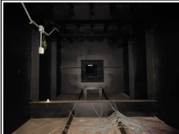
거더 내부 전경
