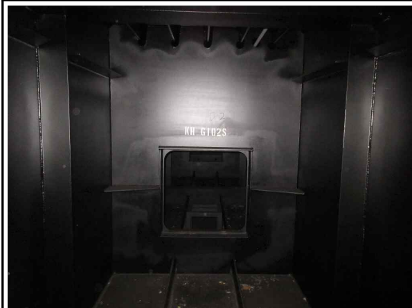
거더 내부 전경
