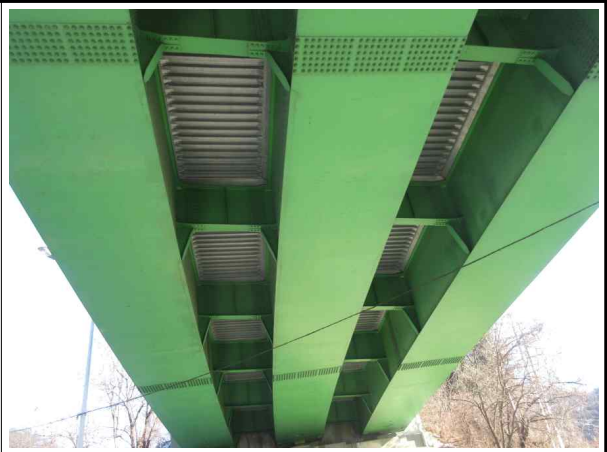
거더 외부 전경
