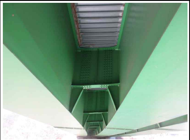
거더 외부 전경
