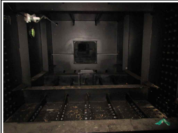
거더 내부 전경
